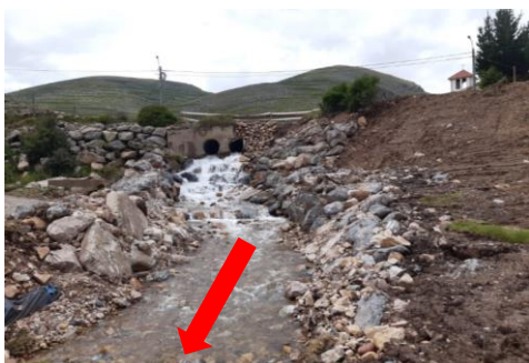
Colmatación del riachuelo el cual podría ocasionar daños en las alcantarillas y en las viviendas alrededor.
