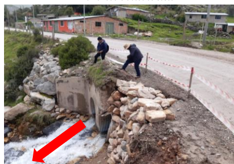
En la imagen se observa el colapso de la Alcantarilla el cual viene provocando erosión en la vía hacia la ciudad de Cusco.
