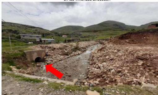
Colmatación del riachuelo el cual podría ocasionar daños en las alcantarillas y en las viviendas alrededor.
